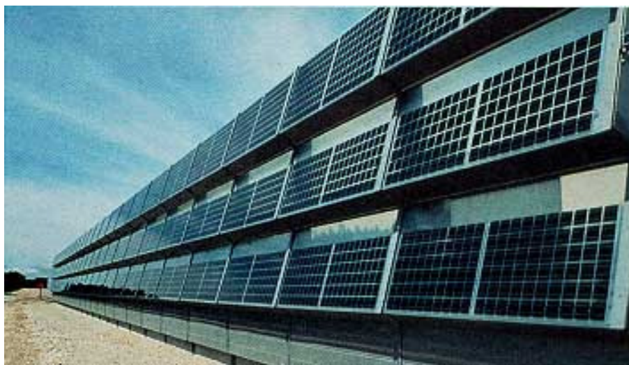
Prototype de mur antibruit photovoltaïque de 10 kWc sur A96 à Munich
